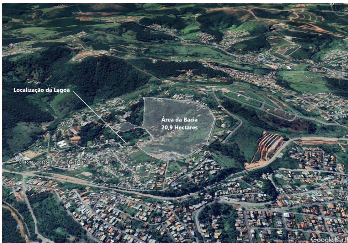
Figura 2. Vista aérea com identificação da bacia de contribuição do empreendimento na Alameda Padre Carlos
