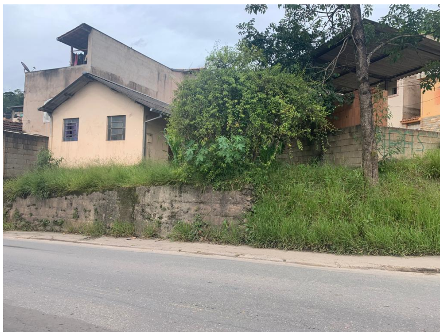
VISTA DA ÁREA PARA URBANIZAÇÃO E BASE PARA O NOVO BOOSTER
