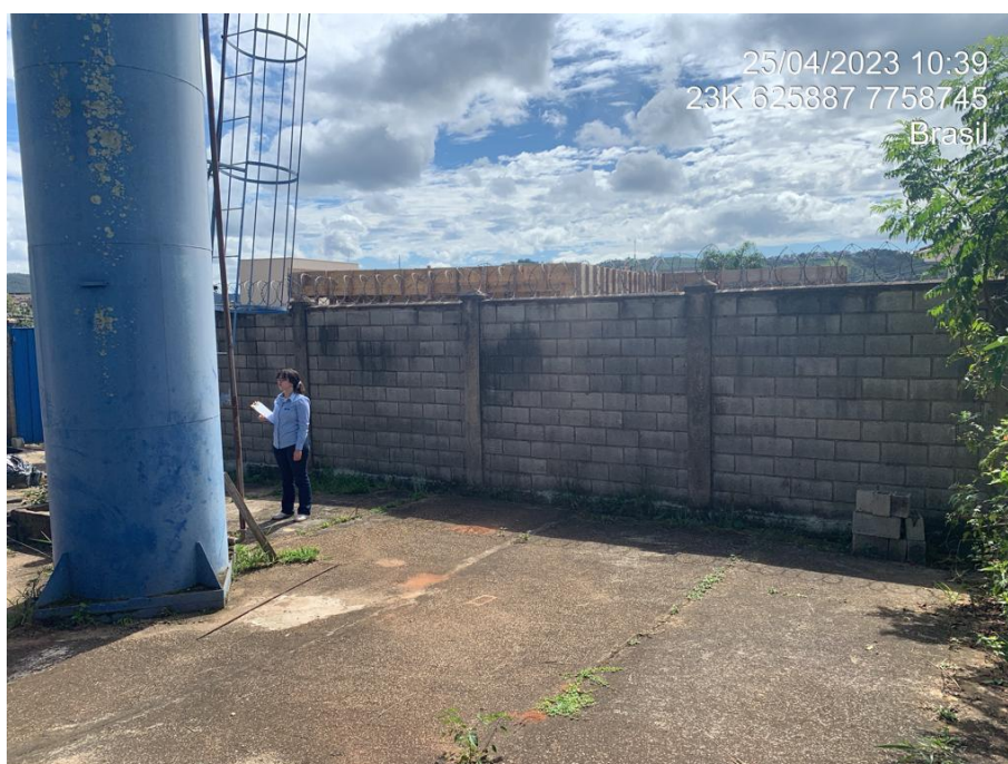
ÁREA INTERNA DO RESERVATÓRIO GARDEN VILLE
