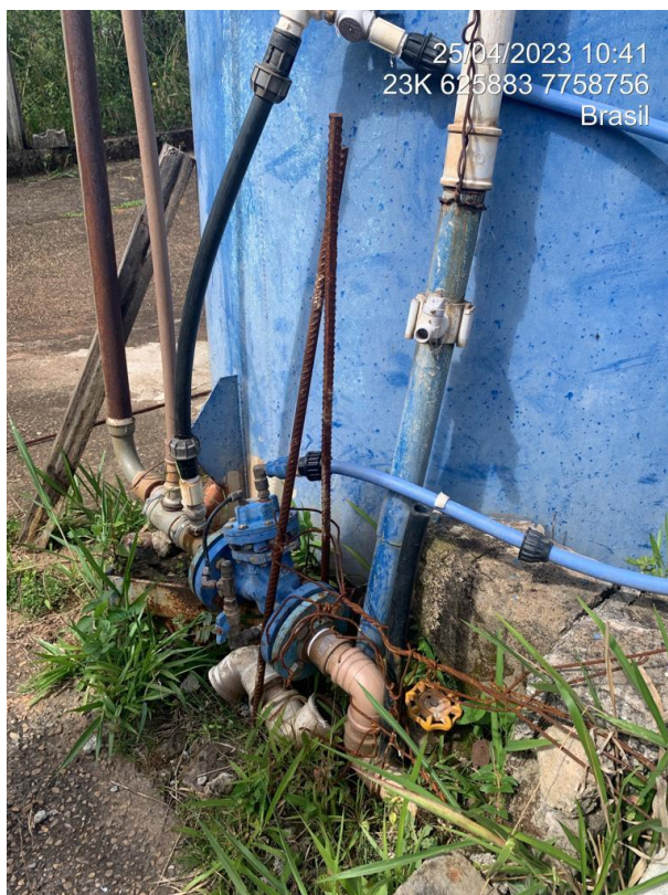
BASE DO RESERVATÓRIO
