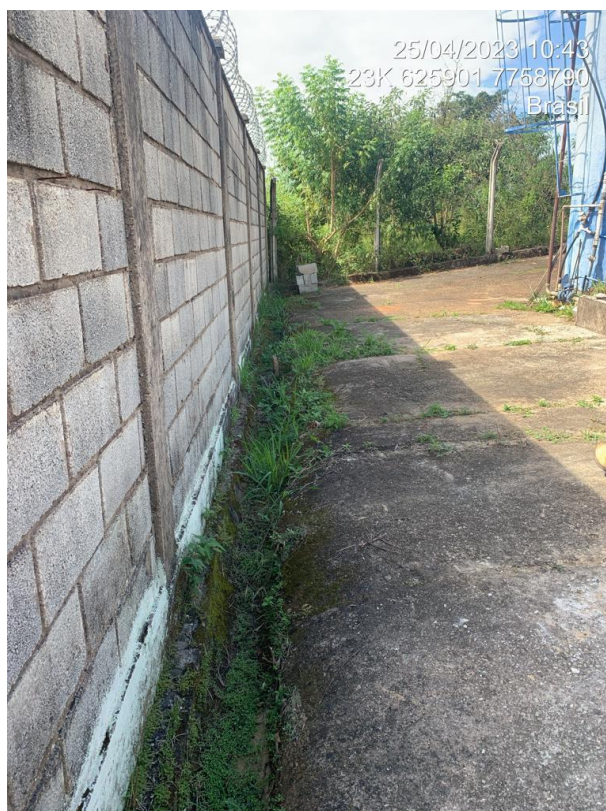
CANALETA DE DRENAGEM INTERNA
