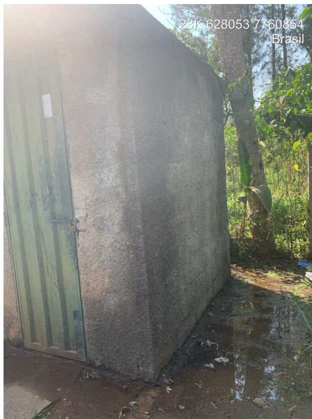
LOCAL PARA CÔMODO DE ABRIGO SISTEMA ELÉTRICO
