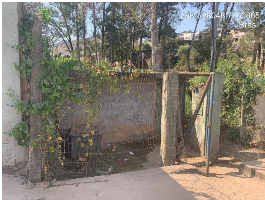
FACHADA DA CASA DE BOMBAS
