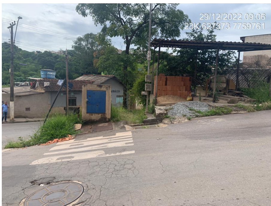
LOCAL DO BOOSTER ATUAL
