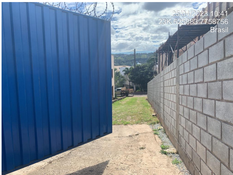
PORTÃO VEICULAR DE ACESSO AO RESERVATÓRIO
