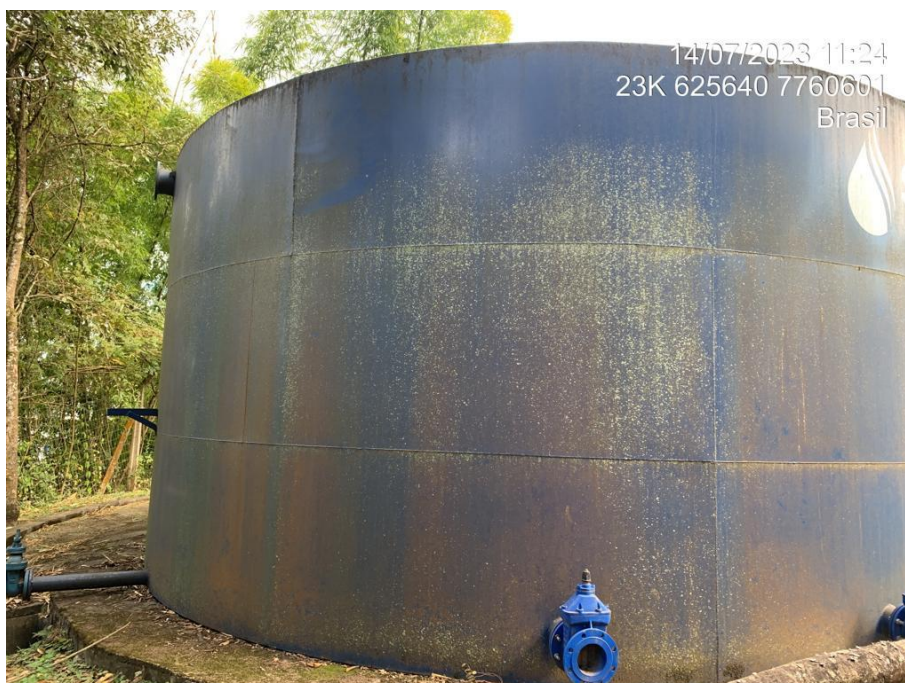
RESERVATÓRIO BELA VISTA A RECEBER NOVA PINTURA
