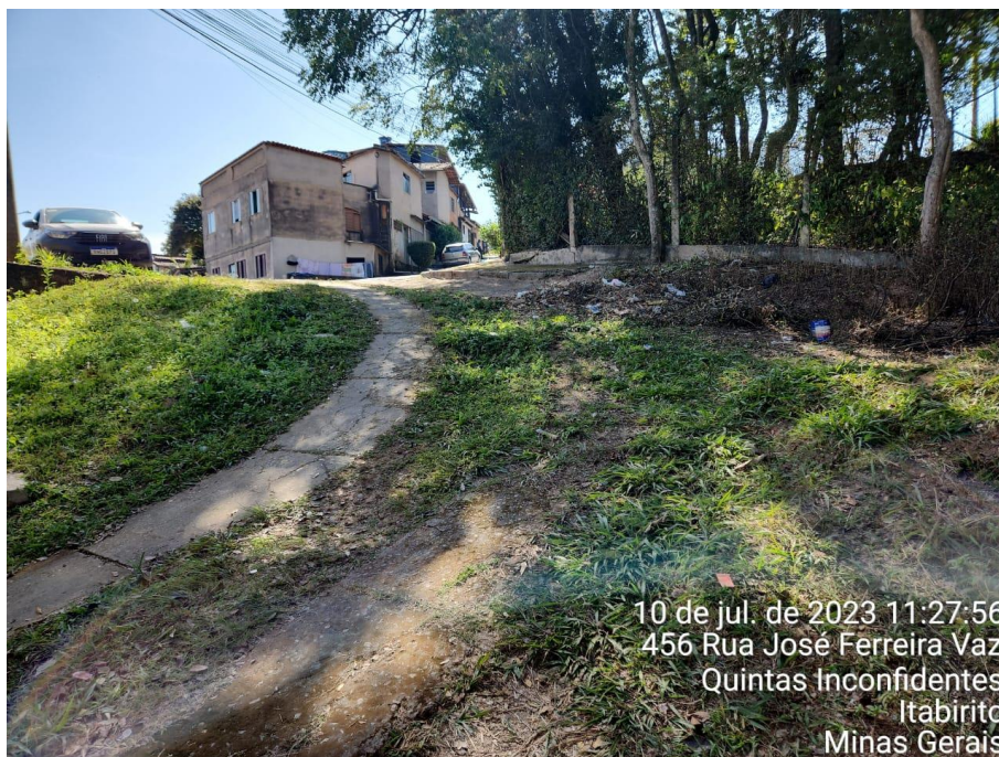
ACESSO AO RESERVATÓRIO BELA VISTA
