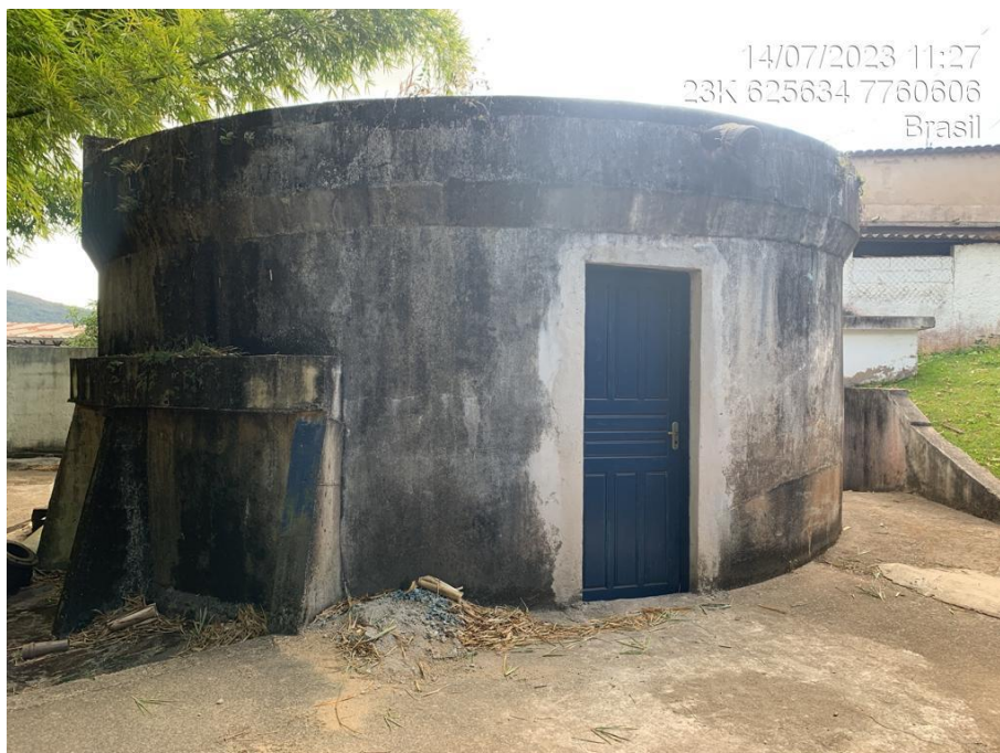
RESERVATÓRIO DESATIVADO A SER TRANSFORMADO EM DEPÓSITO
