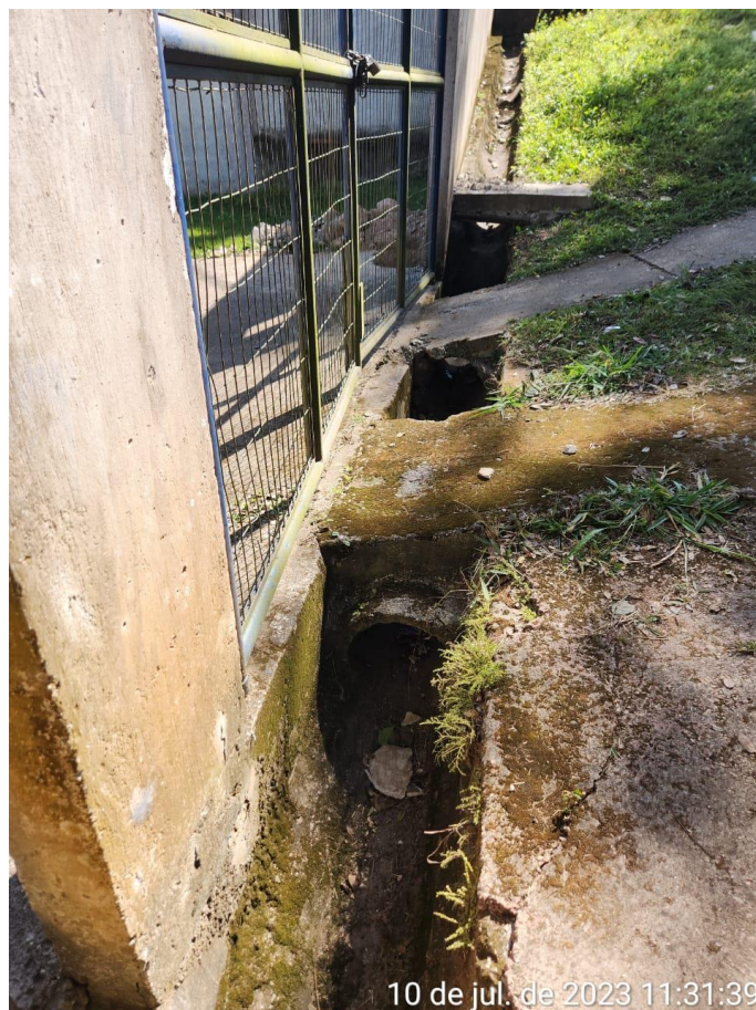
ENTRADA DO RESERVATÓRIO BELA VISTA
