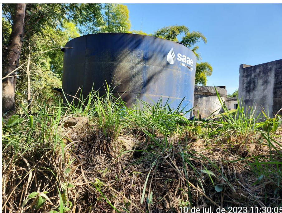
TALUDE DA ÁREA INTERNA DO RESERVATÓRIO BELA VISTA
