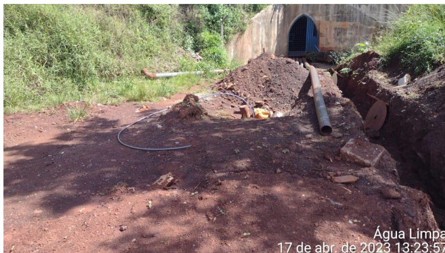
Água Limpa 17 de abr. de 2023 13:23:57 INÍCIO DA ADUTORA – SAÍDA DO MINI TÚNEL – CAIXA 01
