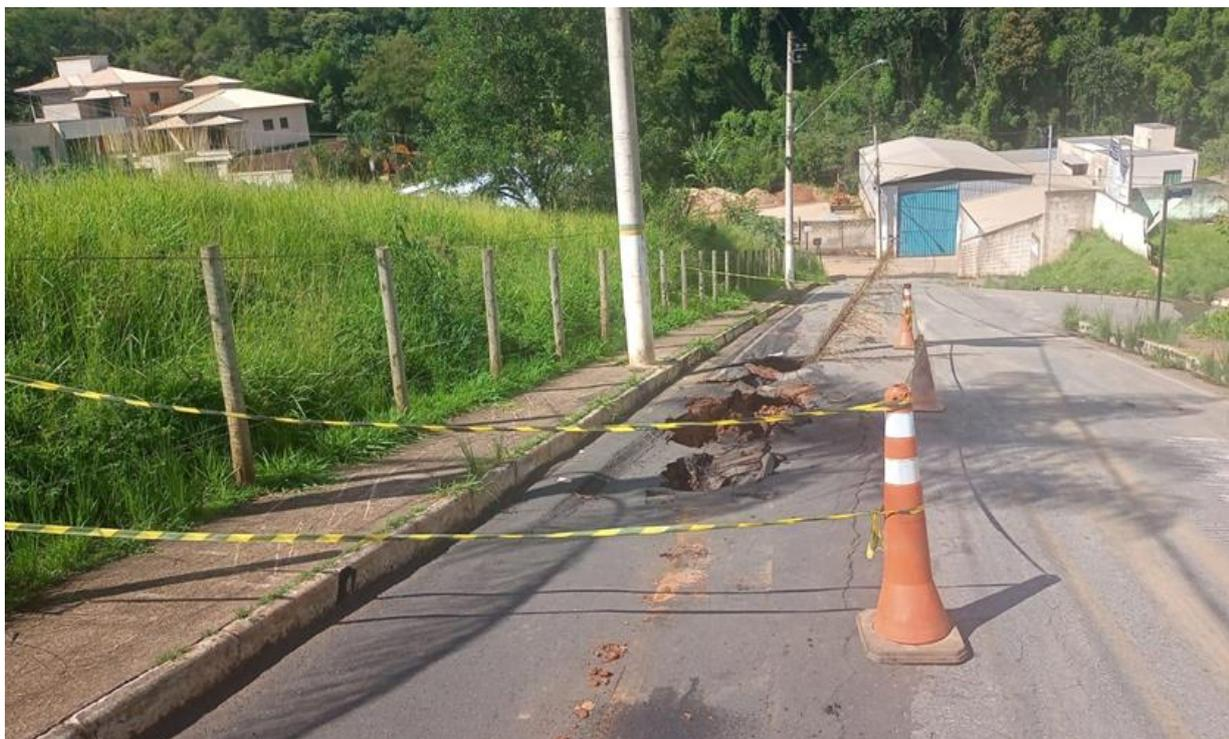
Figura 8. Trechos de afundamento da via ao longo do sistema de drenagem pluvial.
