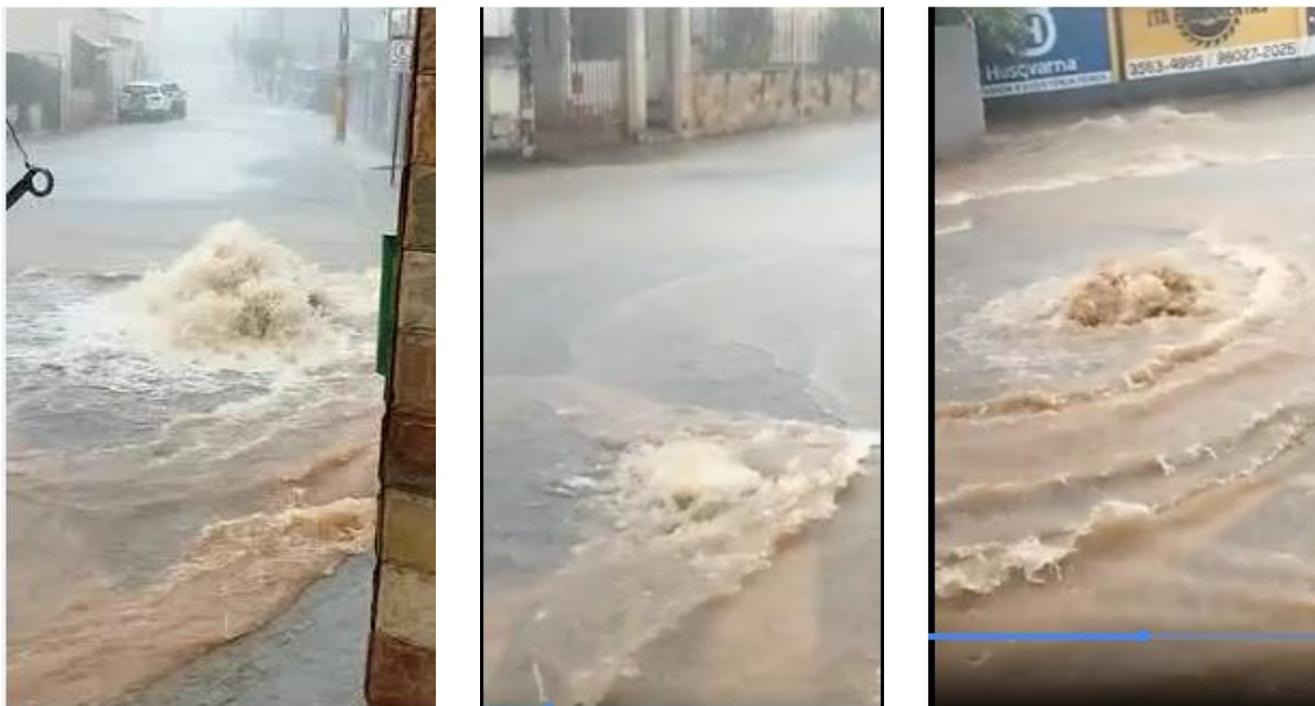
Figura 6. Sobrecarga do sistema de drenagem pluvial nos períodos de fortes chuvas.
