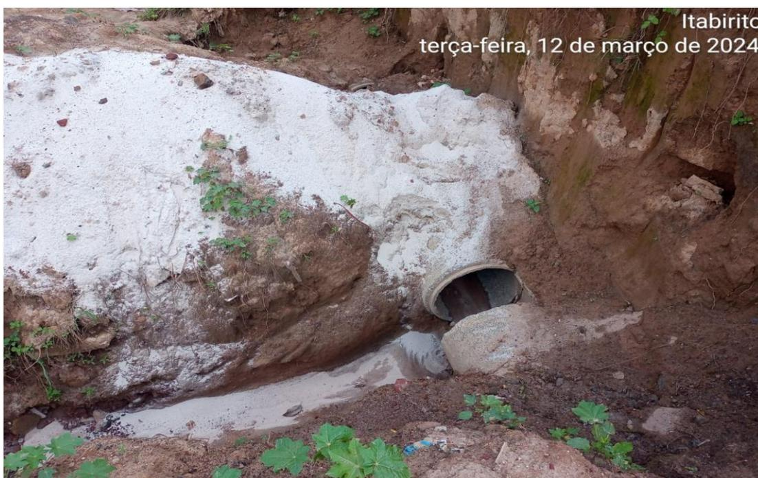
Figura 7. Rede de drenagem pluvial obstruída.
